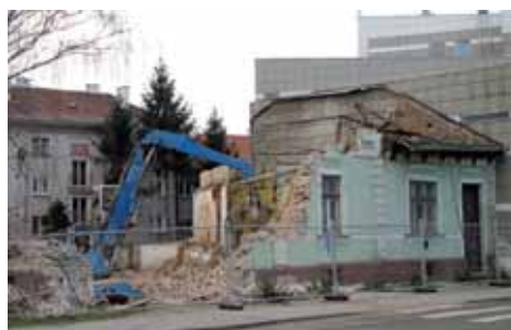
Búranie starého domu.
