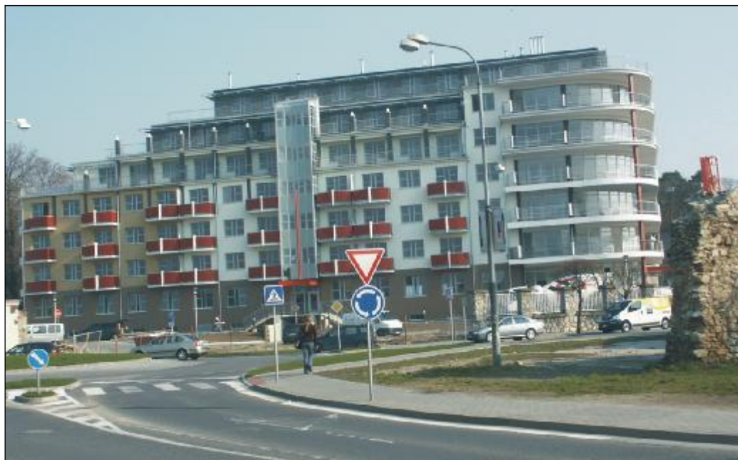
Výstavba domu pred Zámockým parkom sa dostáva do finále.
