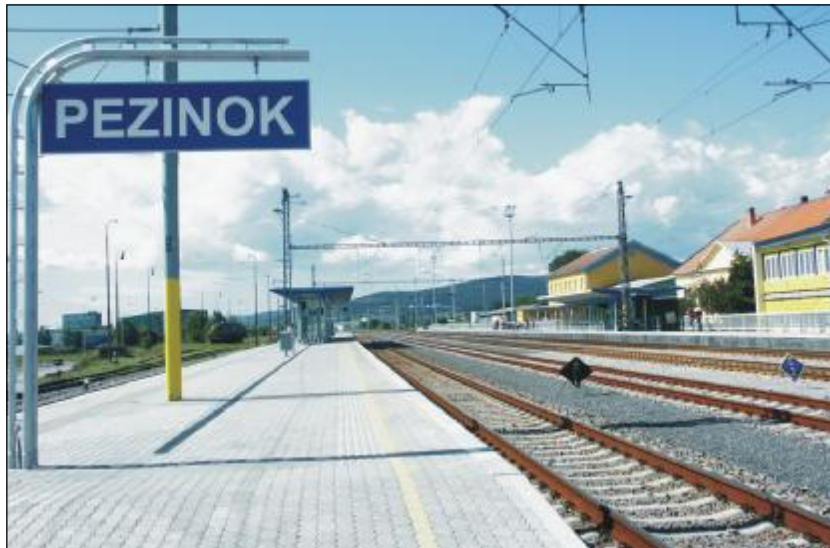
Železničná stanica v Pezinku po rozsiahlej rekonštrukcii.
