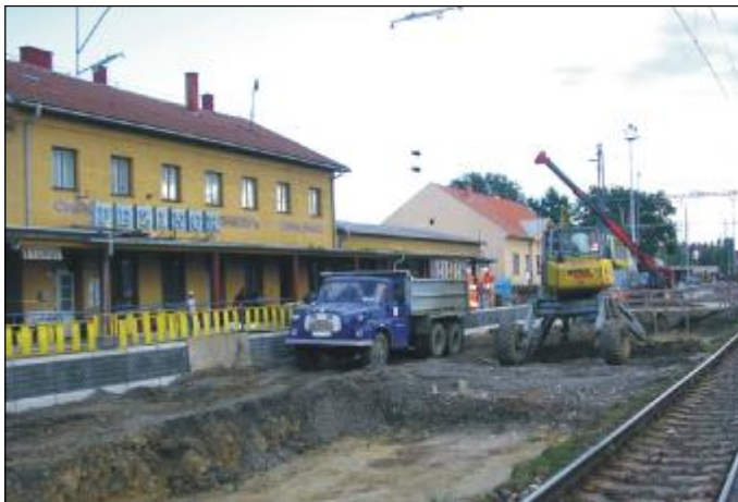
Rekonštrukcia železničnej stanice v Pezinku.
