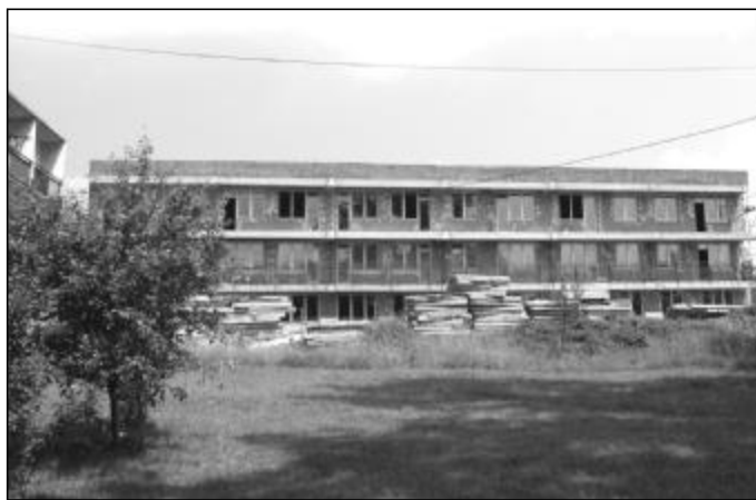
Prestavba rozostavaného zdravotníckeho pavilónu na malometrážne byty na Zumberskej ulici. Snímka (mo)
