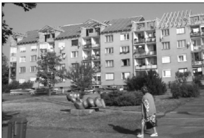
Nadstavba bytovky na ulici 1. mája.
