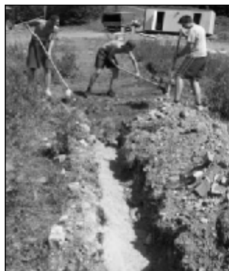
Brigádnic pri výkope ryhy na elektrický kábel. Snímky (mo)
