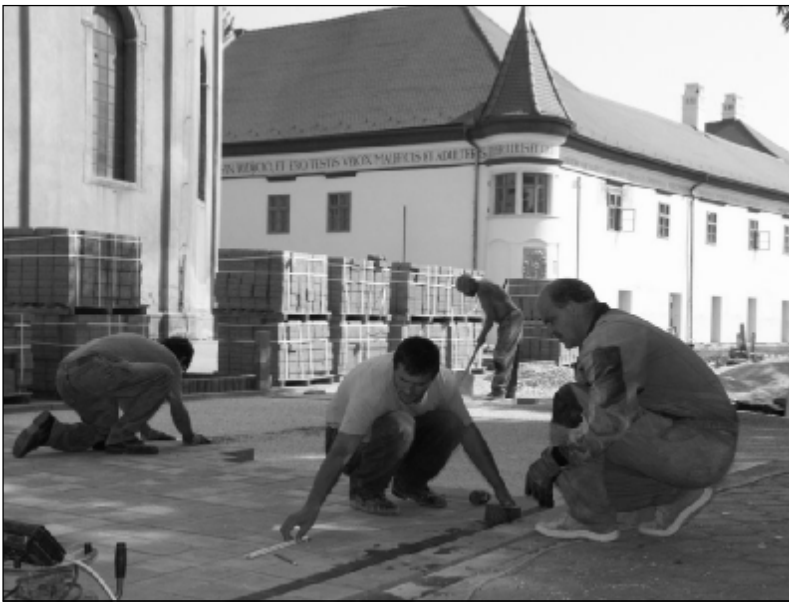
Pracovníci firmy Petmas pri kladení zámkovej dlažby v okolí renovovanej Staréj radnice.
